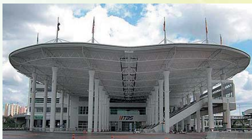
Tasik Selatan Bus Terminal
